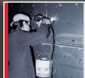
Welding-on wave anchors type KWA
